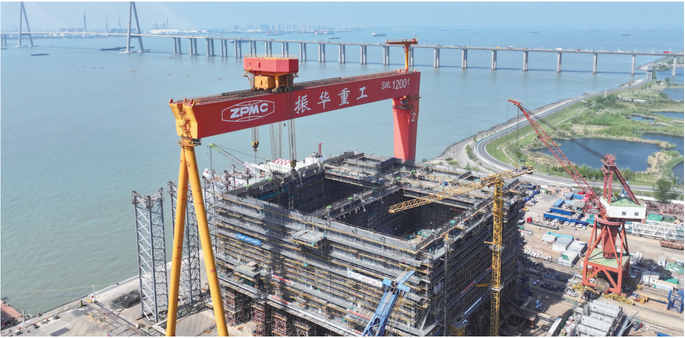
20日,上海振华重工南通振华重装忙碌吊装±500kV海上换流站项目。该项目为7层钢结构平台,已完成一至四层分段吊装。据悉,今年南通振华重装在手订单充足,眼下企业8大钢结构桥梁项目、2座大型换流站项目、5座大型海工船舶工程等多个起重机、龙门吊项目同步进行,生产建造任务有序推进。
